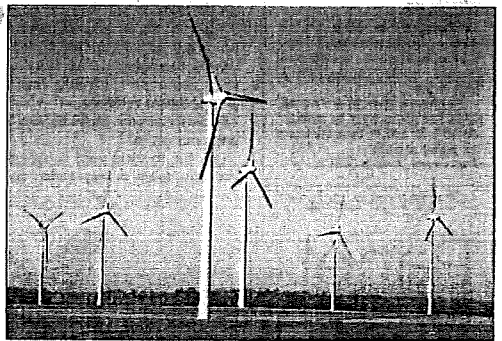
Le parc éolien de Fruges, avec soixante-seize machines, est l'un des plus importants de France. PHOTO ARCHIVES JEAN-HERNÉ BILLET
